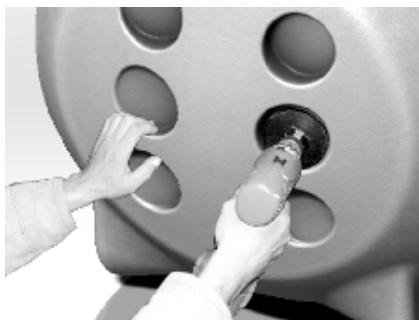
Рис. 13 Сверление отверстия для установки ЗПТ
