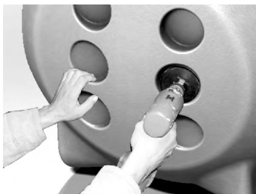
Рис. 11 СВЕРЛЕНИЕ ОТВЕРСТИЯ ДЛЯ УСТАНОВКИ ЗПТ
