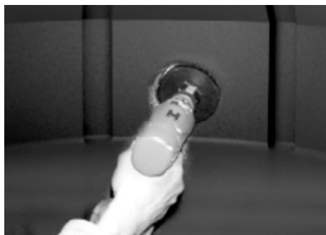
Рис. 10 Сверление отверстия для установки ЗПТ
