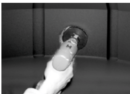
Рис. 10 Сверление отверстия для установки ЗПТ
